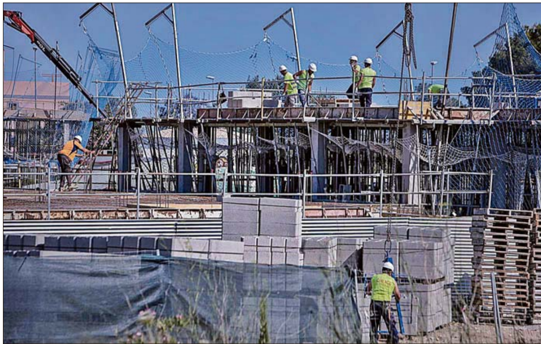
Obras para la construcción de nuevas viviendas en Palma. B. RAMON
