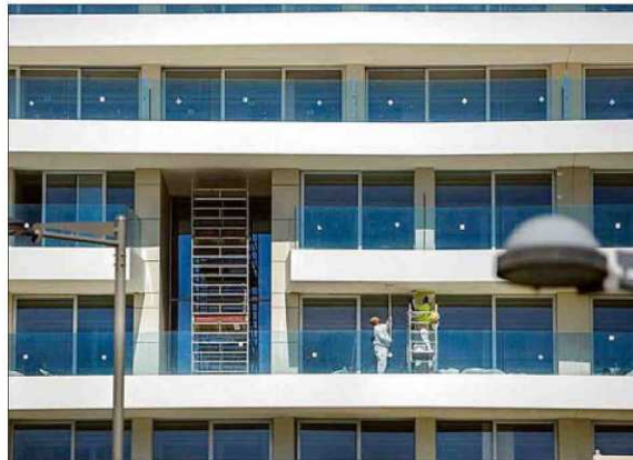
Obras de ampliación de un establecimiento hotelero. B. RAMON
