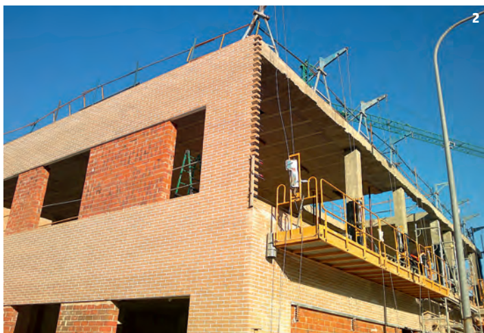
Fig. 1: fachada de ladrillo cara vista (L.C.V.) a tizón con ornamentos geométricos.
