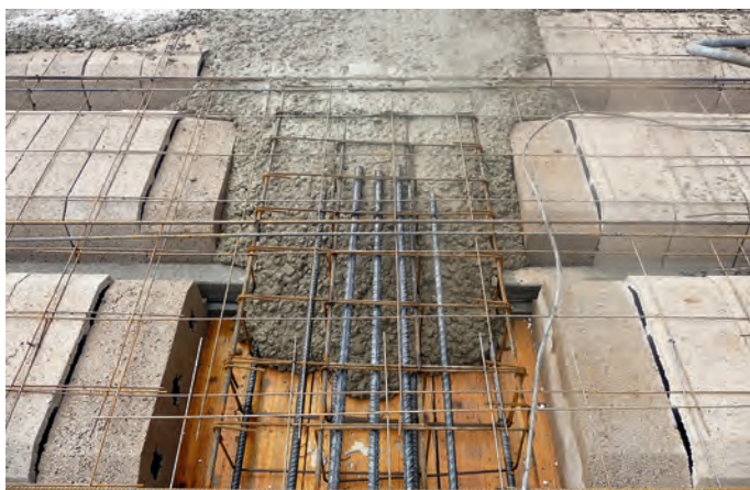
Fig. 1: vista general de forjado unidireccional.
