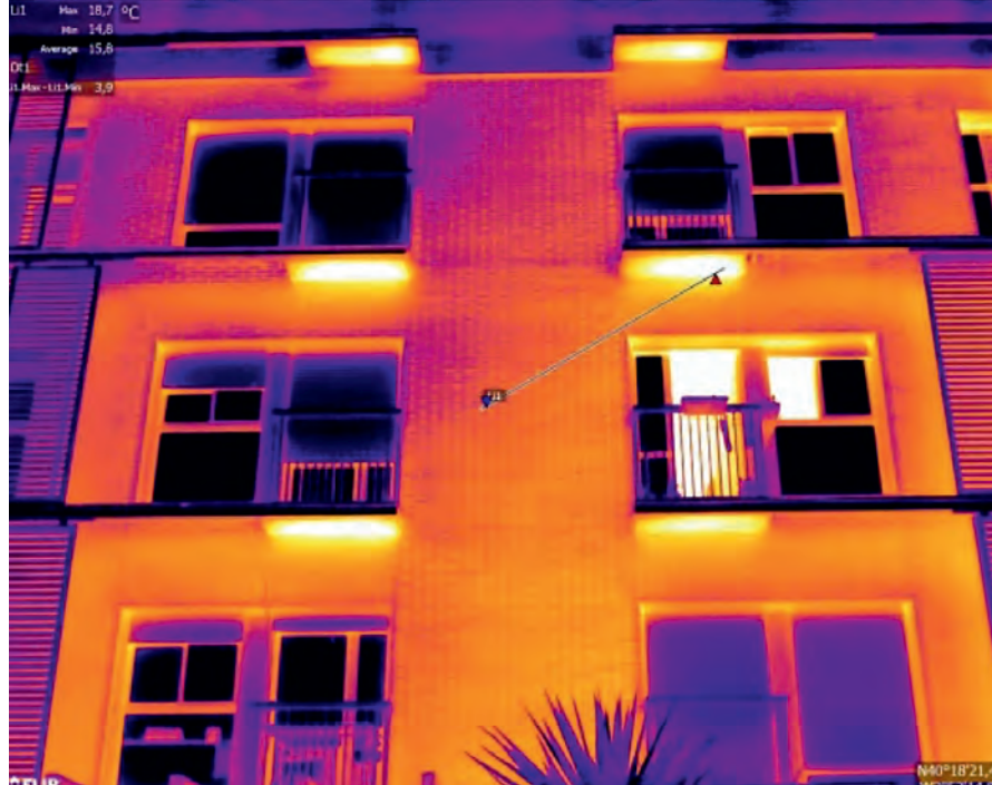
PUENTE TÉRMICO Termografía de una fachada autoportante sin puentes térmicos.
