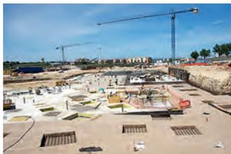
**2** Previa a la impermeabilización, se realiza una capa de grava, de unos 20 cm, y otra de hormigón de limpieza rico en cemento.
