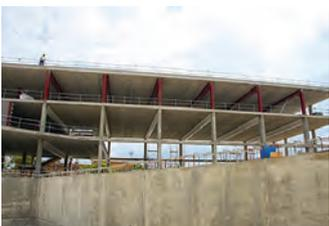
**3** En la zona donde se proyecta la piscina semiolímpica, el forjado de techo tiene unas luces entre pilares de 17 m y no se ejecuta forjado intermedio.
