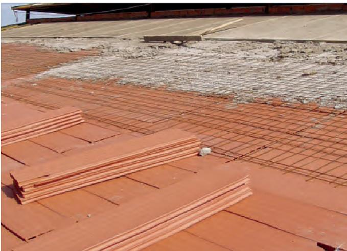
Fig. 1: extendido de capa de mortero sobre tablero cerámico.
