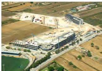
**1** Al comenzar la excavación se descubre que el suelo no es uniforme, algo que no se había detectado en el estudio geotécnico. Esto obliga a recalcular toda la cimentación.
