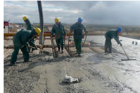
Fig. 35: fase de hormigonado de forjado.
