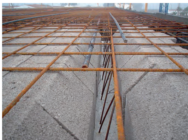
Fig. 29 y 30: colocación de armado de negativos y mallazo de reparto.
