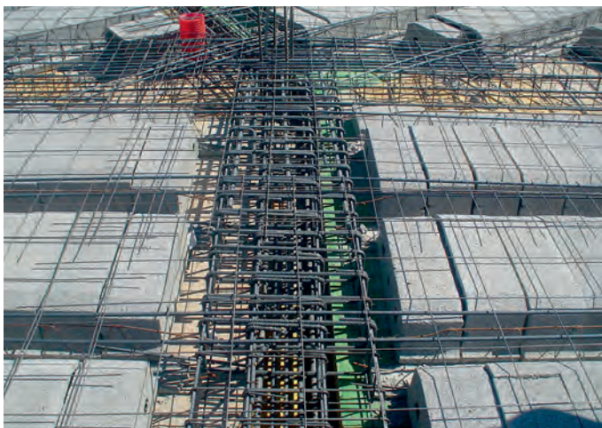
Fig. 1: vista general forjado unidireccional.
