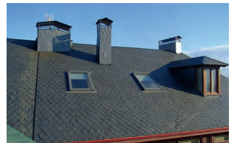
Fig. 6: tejado de pizarra con la existencia de distintos puntos singulares: canalones, ventanas, chimeneas, juntas de dilatación...
