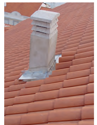
Fig. 7: encuentro de un faldón con un shunt.
