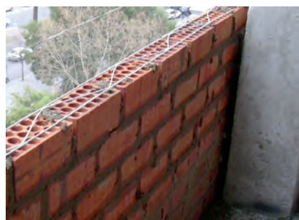
Fig. 1: colocación de armadura de tendel en la hoja principal.
