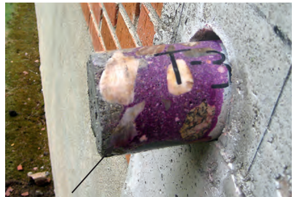
Figura 2: carbonatación del hormigón.
