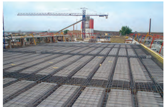
Figura 1: vista general de una estructura de hormigón armado.
