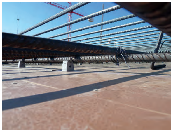
Figura 4: colocación de separadores para garantizar el recubrimiento.
