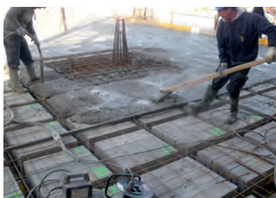
Figura 17: fase de hormigonado: vibrado y extendido del hormigón.
