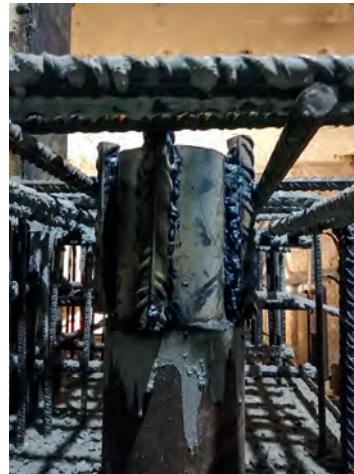
FIGURA 6 Camisa metálica embebida en encepado provisional.
