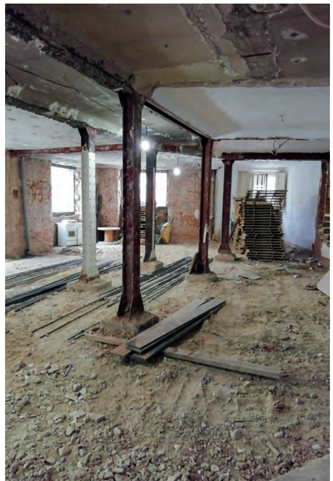
FIGURA 3 Pilares metálicos de la estructura porticada.
