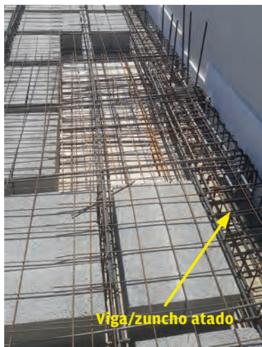
Figura 9: armado de vigas y/o zunchos.
