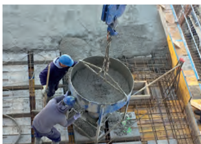
Figura 16: fase de hormigonado: vertido de hormigón con cubilote.
