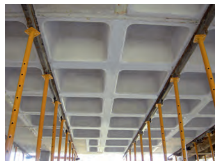
Figura 4: aligeramiento del forjado reticular con moldes recuperables.
