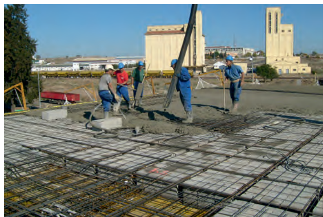
Figura 2: hormigonado de forjado reticular.
